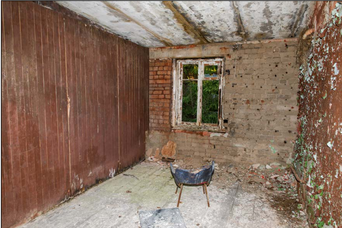
Foto 13 (387). Tsitre kordon. Peahoone [2] - kasutatud on kõiki materjale: raudbetoonpaneel, krohv, tellis, puit, põrandal kiviplaadid. Foto Mart Mõniste 23.04.2014.
