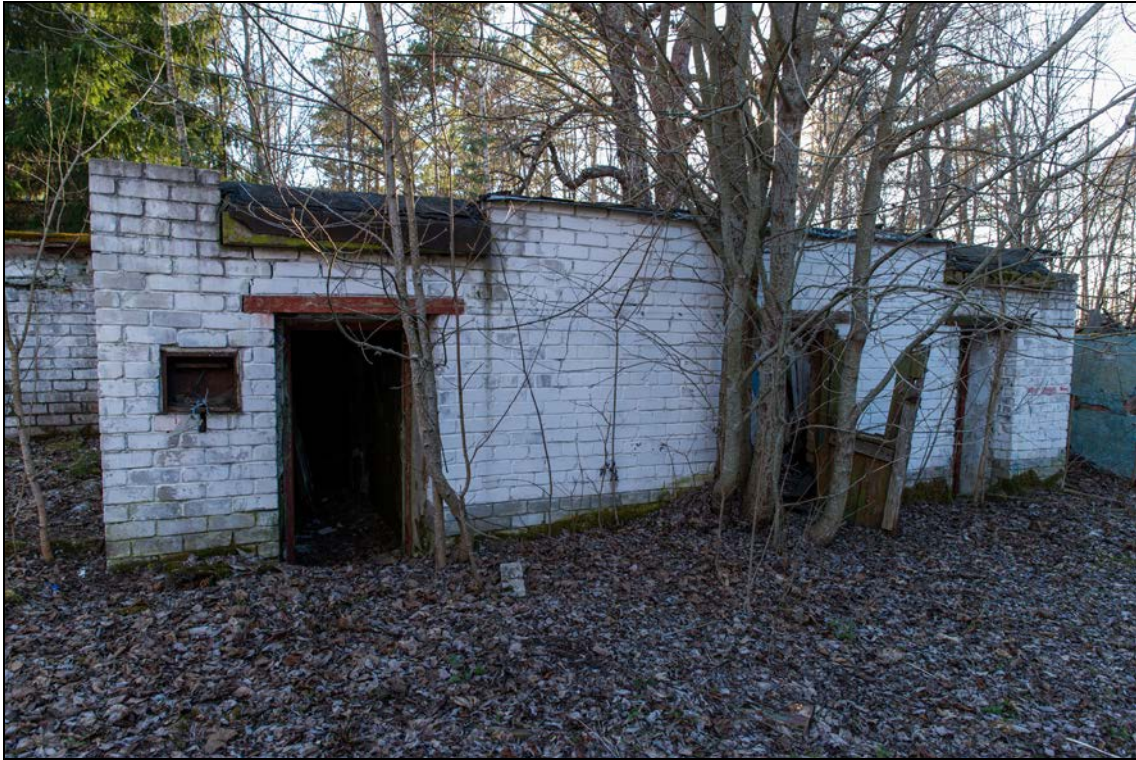
Foto 35 (283). Tsitre kordon. Kelder [7] on algselt laotud paekivist, hiljem on lisatud tellisvooder. Paremalt paistab relvakontrolli post. Foto Mart Mõniste 23.04.2014.
