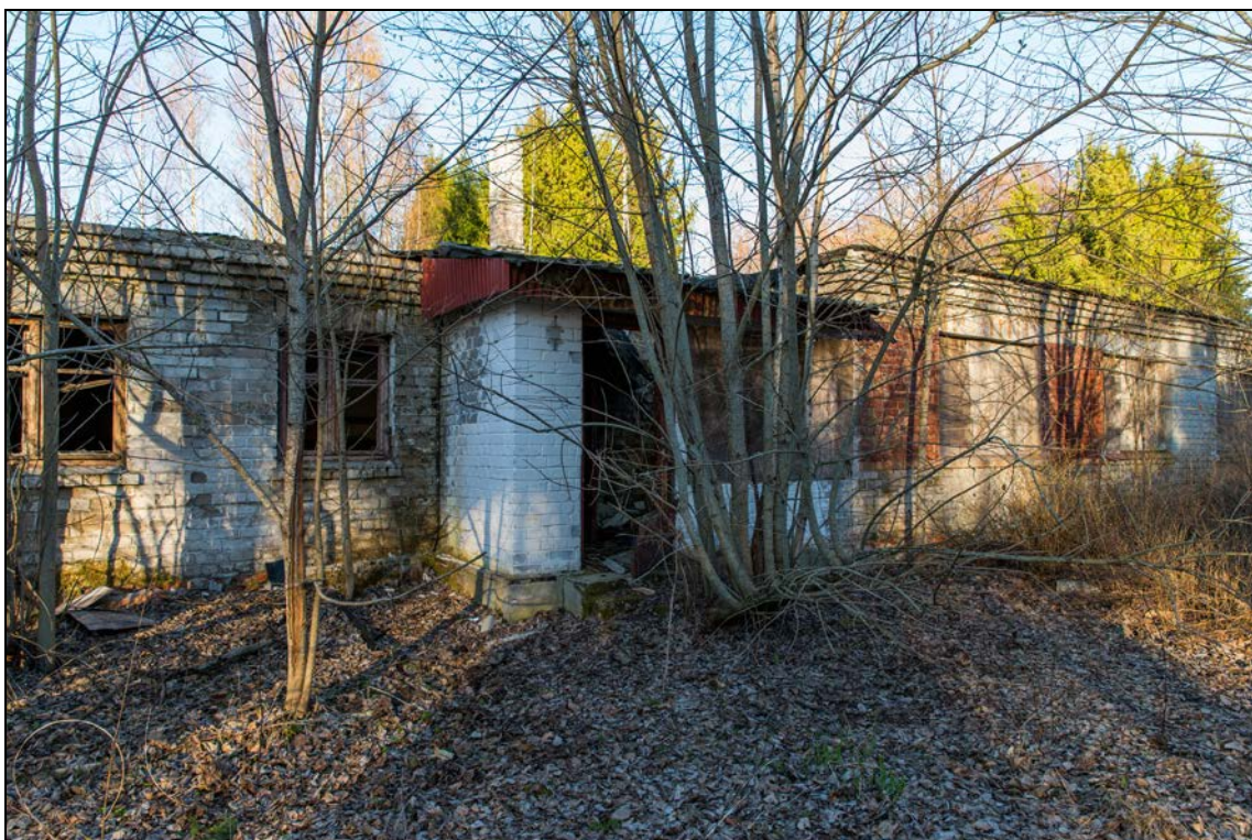
Foto 8 (373). Tsitre kordon. Peahoone [2] on väga sopiline ja ehitatud/ümber ehitatud mitmes järgus. Keskel peasissepääs. Foto Mart Mõniste 23.04.2014.
