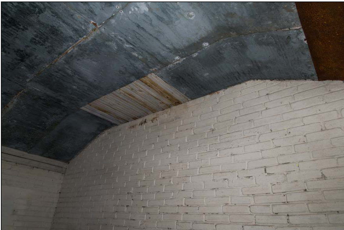
Foto 32 (266). Tsitre kordon. Hoone [6] keskmises osas on aga hoopis omapärane laekonstruksioon. Foto Mart Mõniste 23.04.2014.
