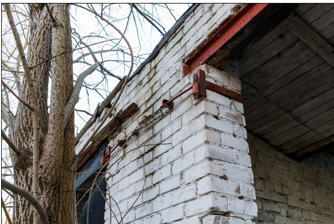
Foto 62 (354). Tsitre kordon. Laut/garaaž [11]. Väravate kinnitusi on tugevdatud lehmaketiga. Foto Mart Mõniste 23.04.2014.
