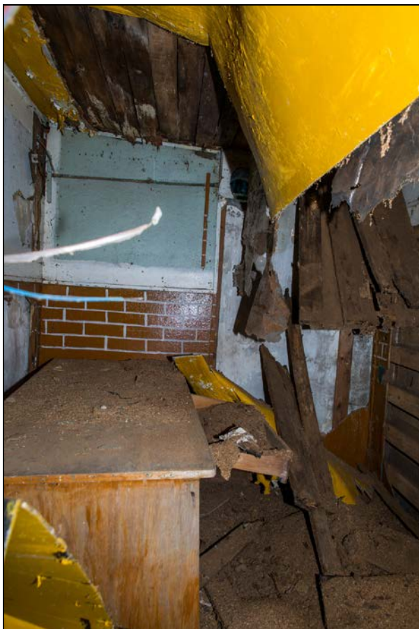
Foto 47 (313). Tsitre kordon. Hoone [9] sise- ja ... Foto Mart Mõniste 23.04.2014.
